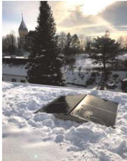
2 Module, Ost-West-Ausrichtung, Foto: H. Rhomberg
