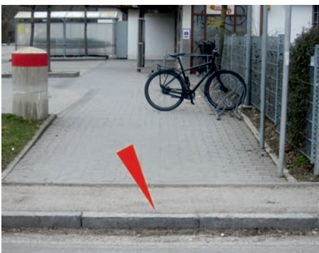
Fehlende Bordsteinabsenkung beim Edeka. Foto: Gerhard Hippmann
