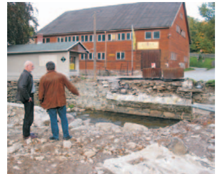
Eine der weggerissenen Brücken
