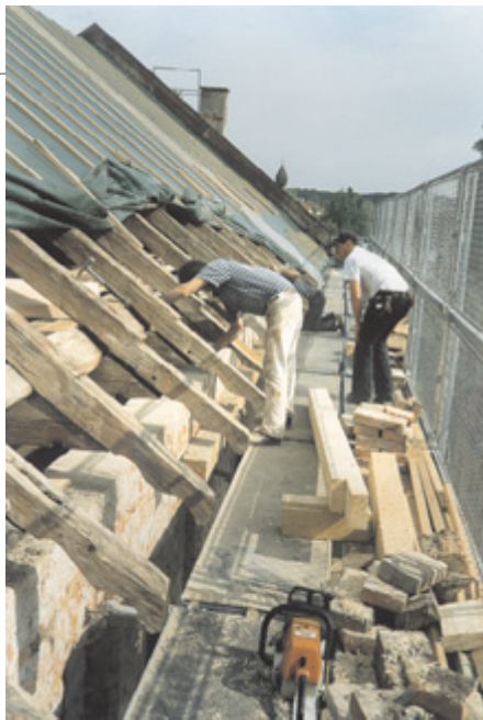
Dachsanierung am Pfarrstadel, 2000 Archiv Verein "UNSER DORF"
