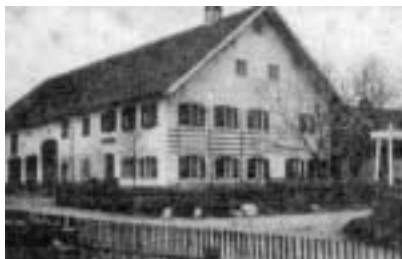
Das «Klotz-Haus» vor 1909
