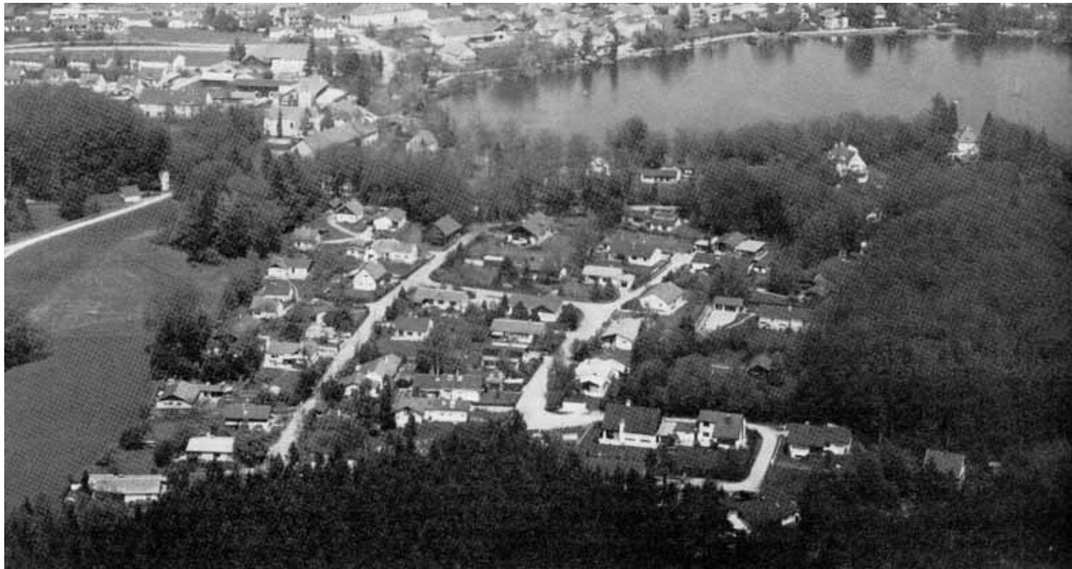
Die Kreuzbergsiedlung im Bildvordergrund. Eine Luftaufnahme aus den 80er Jahren.
