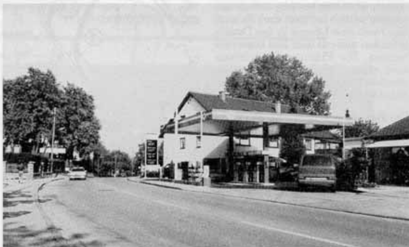
Kein Beitrag zur Verschönerung des Ortsbildes: das neue Dach der Tankstelle in der Hauptstraße
