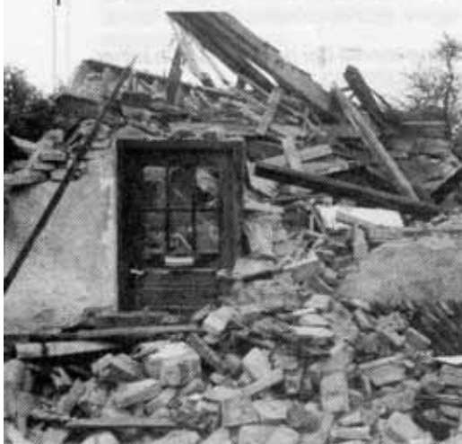
Künftig wird hier ein Mehrfamilienhaus mit Tiefgarage stehen.
