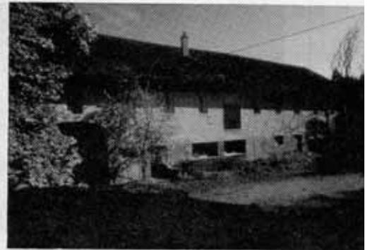
Blick vom Westen auf das imposante, 35 Meter lange Bauwerk
